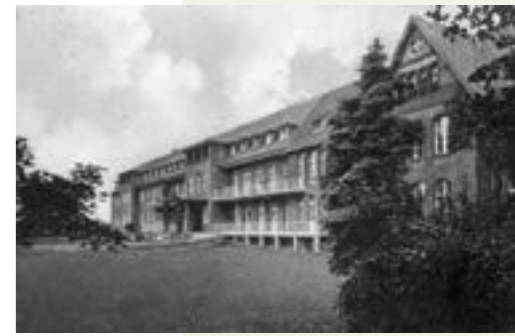
Das nach Süden erweiterte Johanniter-Kreiskrankenhaus, um 1935.
